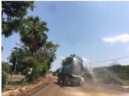
รูปที่ 2-11: การฉีดพรมน้ำบนเส้นทางขนส่งแร่ ช่วงที่ผ่านชุมชน
